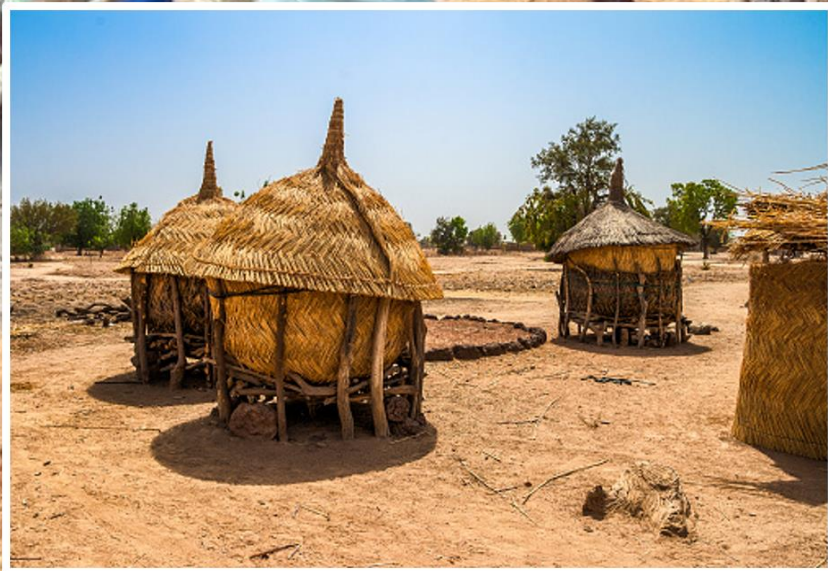
Construção de celeiro resistente à enchentes em Lumbo, Moçambique
