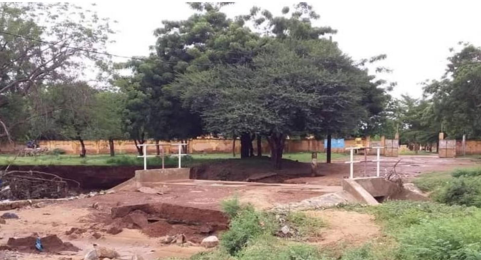
*Image 4 : Dégât des pluies sur l'ouvrage de franchissement du lycée Fodié Maguiraga de Nioro*
