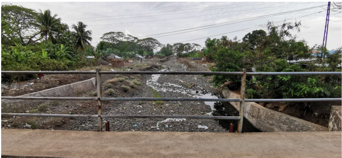
Fig. Aménagement sur le lit du cours d'eau à Komotel
